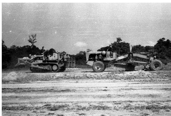
La niveleuse Caterpillar s'est embourbée : Un câble et le bulldozer, et c'est reparti.
