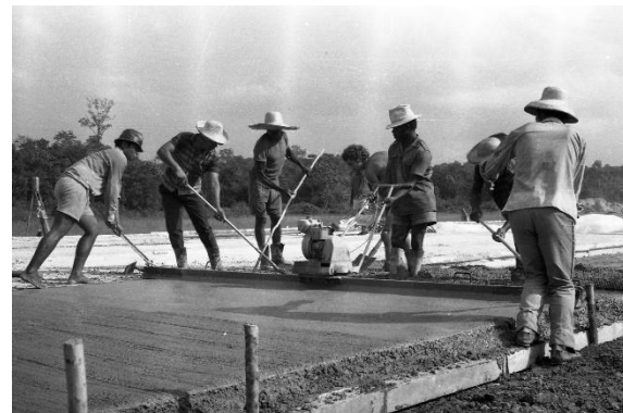
Mise en œuvre au pervibrateur, à l'huile de coude, et à la règle vibrante
