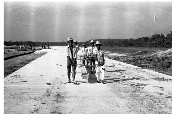
Mise en œuvre au pervibrateur, à l'huile de coude, et à la règle vibrante
