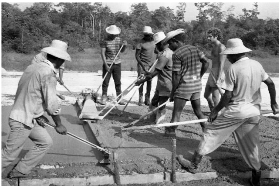
Mise en œuvre au pervibrateur, à l'huile de coude, et à la règle vibrante
