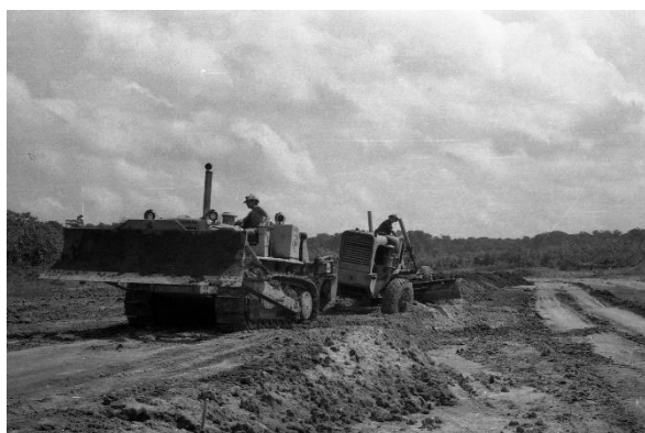
La niveleuse Caterpillar s'est embourbée : Un câble et le bulldozer, et c'est reparti.
