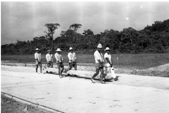
Mise en œuvre au pervibrateur, à l'huile de coude, et à la règle vibrante
